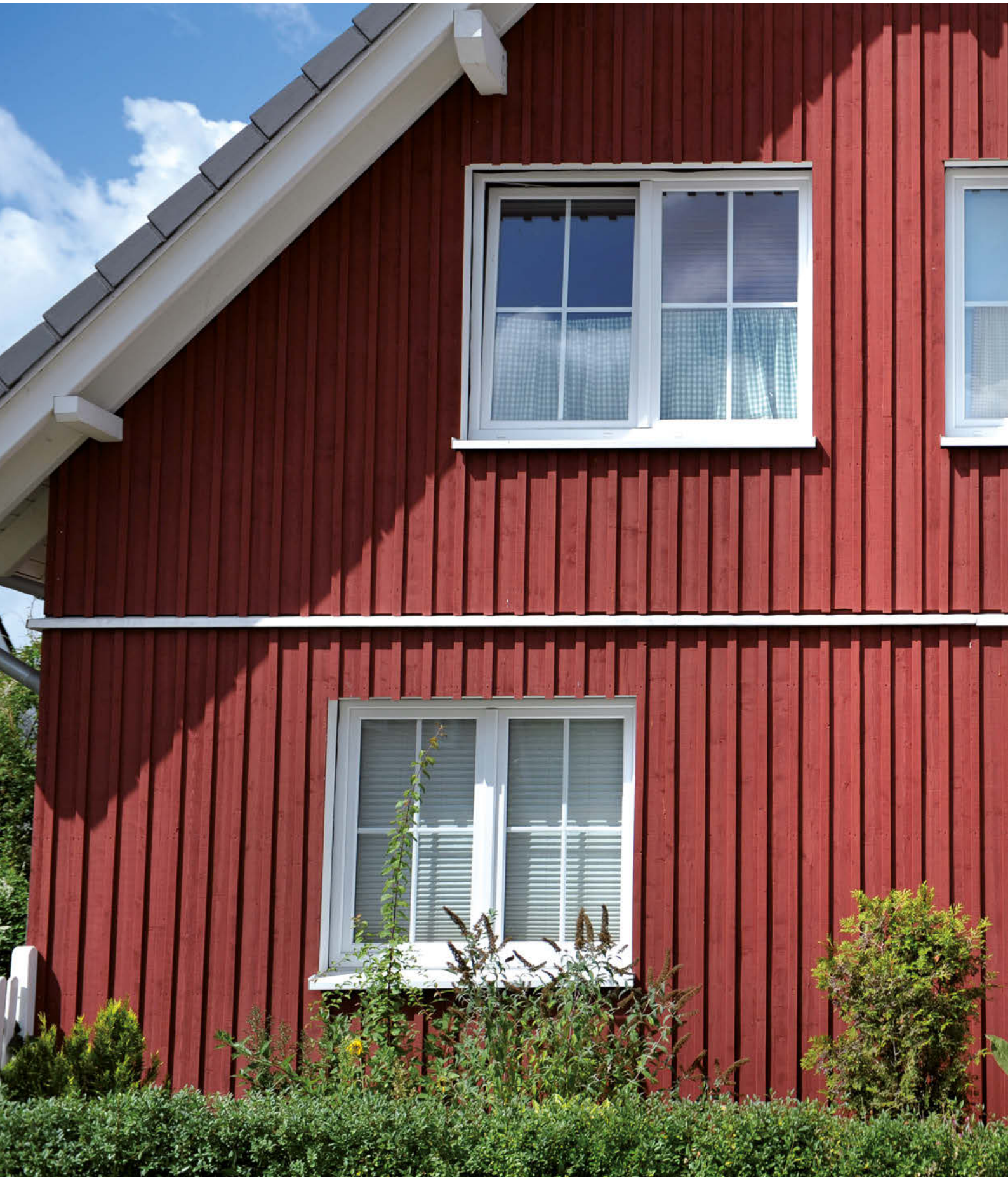
Boden-Deckelschalung, Fichte gesägt, endbehandelt mit Osmo Landhausfarbe 2308 Nordisch Rot
