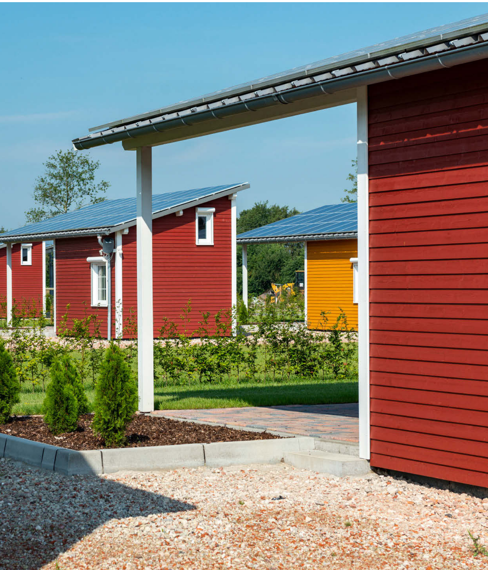
Cono, Fichte gesägt, endbehandelt mit Osmo Landhausfarbe 2308 Nordisch Rot und 2203 Fichten-Gelb
